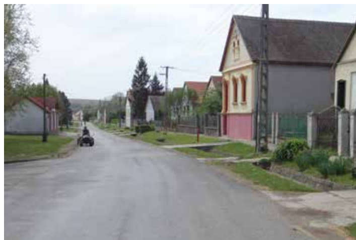
Fekede területén hamarosan elkezdődik a csatornahálózat fektetése
