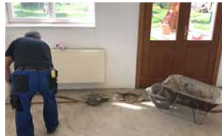
A padlózat törmelékének elszállítása
