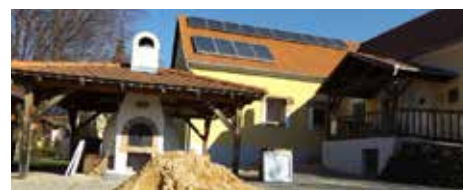
A szálló áramellátását napelemek is segítik
