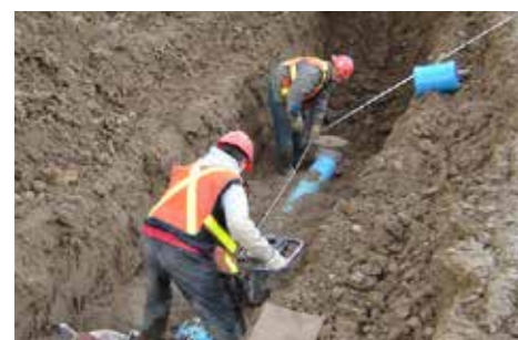
A szennyvízhálózat kiépítése a legköltségesebb beruházás
