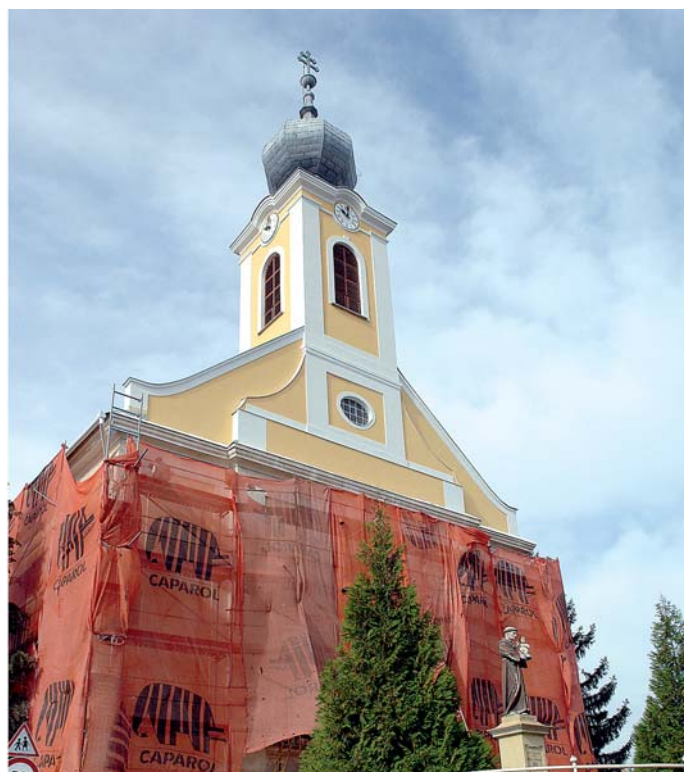
A tervek szerint halad a véméndi katolikus templom felújítása
